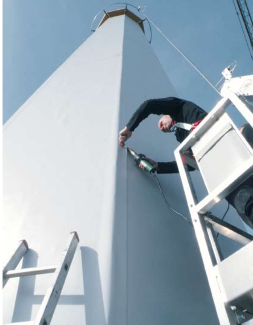
...und außen schützt eine spezielle Membran aus Kunststoff den Turm vor Regen
