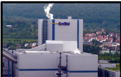
Das Kohlekraftwerk Altbach-Deizisau Foto: Dierk Schaefer, Flickr
